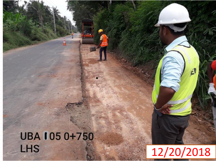
Earth work -UBA105 Ch 0+750(LHS)
